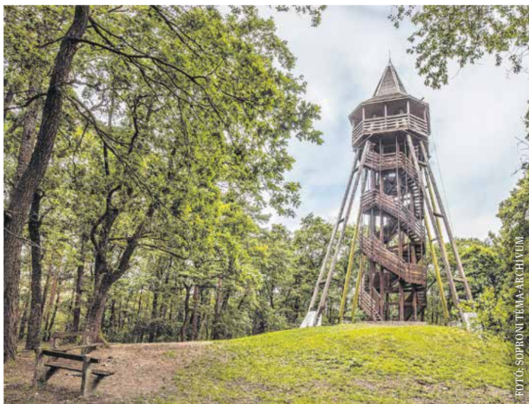
Így mutatott a kilátó a Várhelyen – az életveszélyessé vált épületet lebontotta a TAEG.
